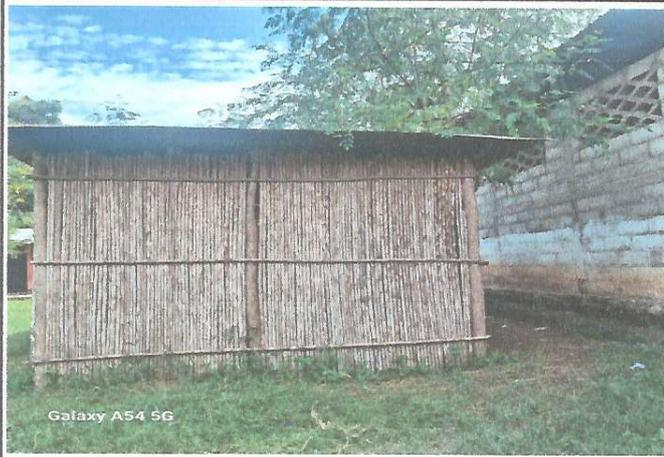
Foto 1: Mejoramiento al Modulo 8 Con Estructura tipo pórtico y estructura de lámina troquelada calibre 26.
