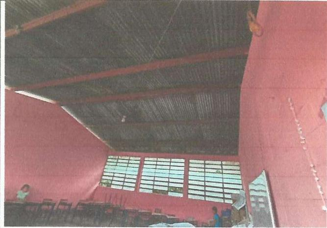
Foto1: Estructura Cubierta de lámina Troquelada Calibre 26 al Modulo 1 .
