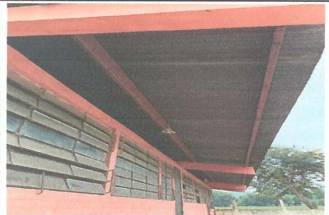
Foto 3: Estructura Cubierta de lámina Troquelada Calibre 26
