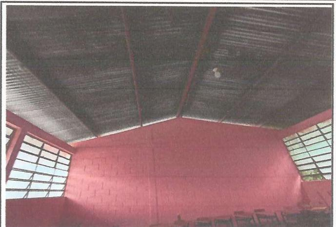
Foto 2: Estructura Cubierta de lámina Troquelada Calibre 26 al Modulo 2 .
